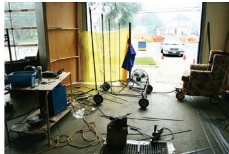
L'atelier du centre-ville, vue de l'intérieur*
